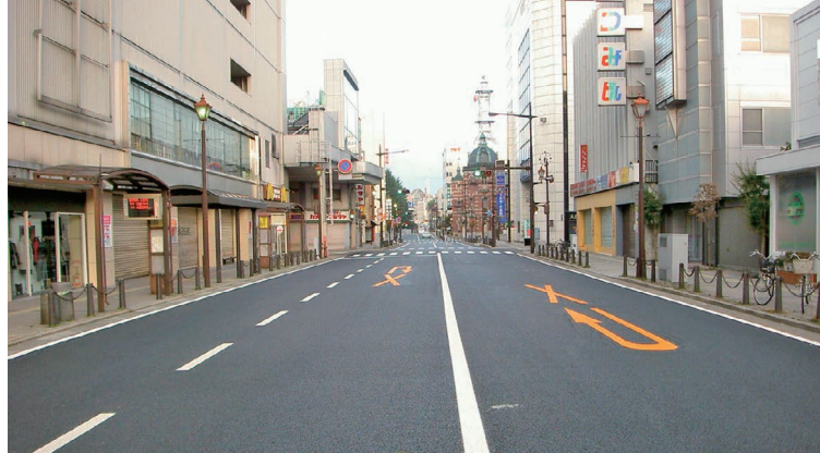
2009年竣工 一般国道106号築川地区他道路舗装補修工事
