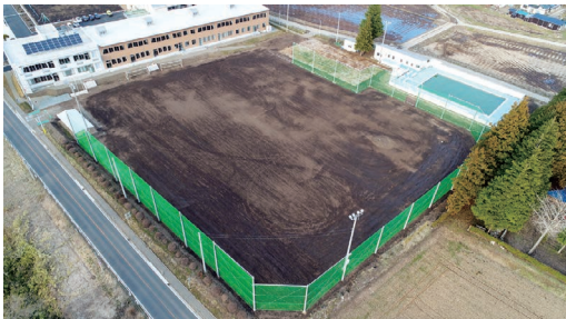
紫波町立紫波第二中学校グラウンド整備工事
